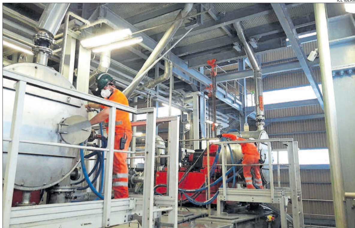
Planta de cristallització d'ICL Iberia a la mina de Súria
