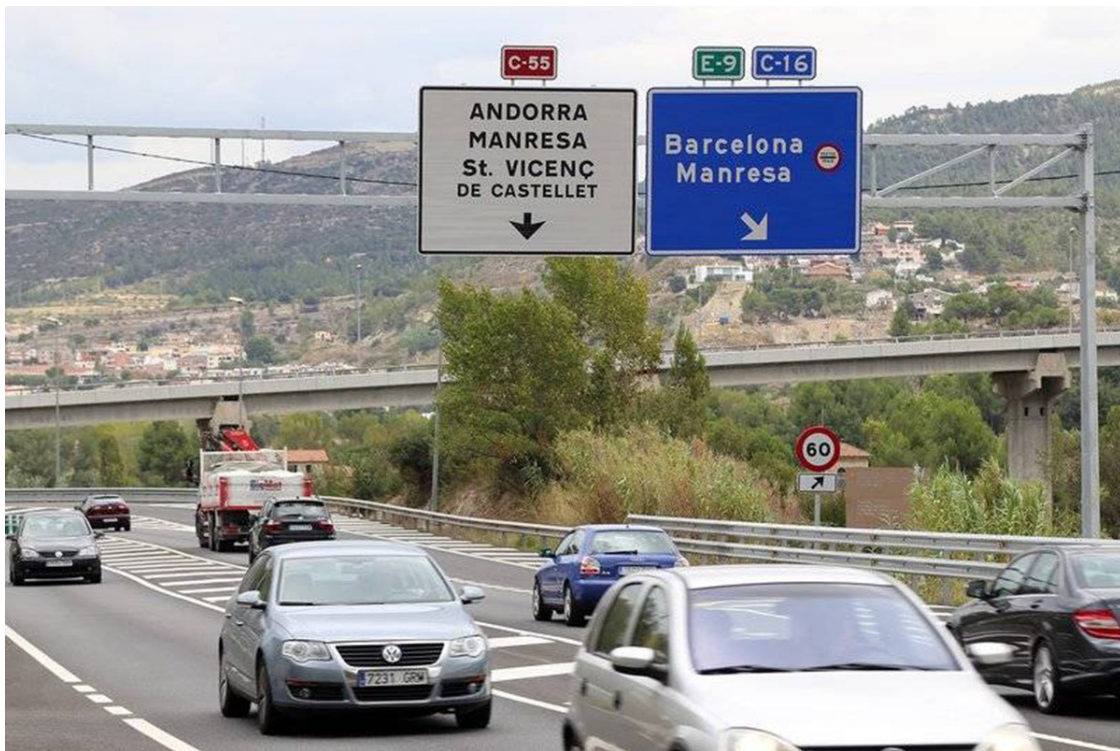
Entrada a l'autopista des de la C-55 a l'altura de Sant Vicenç | Arxiu
