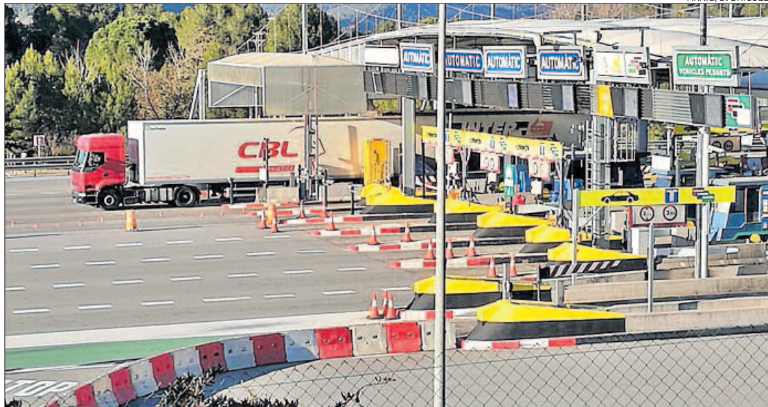
El Govern preveu aplicar l'1 de setembre l'obligatorietat del teletac per a tots els descomptes a de la C-16
