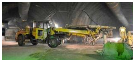
Màquina treballant a l'interior de la mina de Súrria. icl
