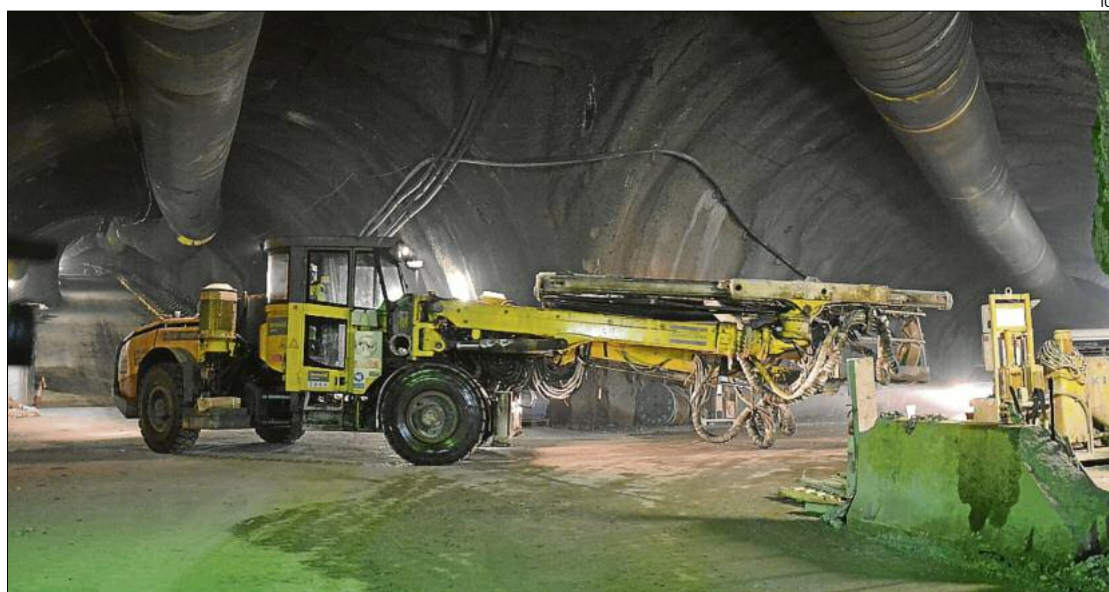
Màquina treballant a l'interior de la mina de Súria
