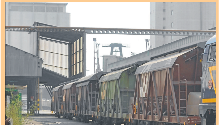
El projecte comportarà la millora i el transport de mercaderies
