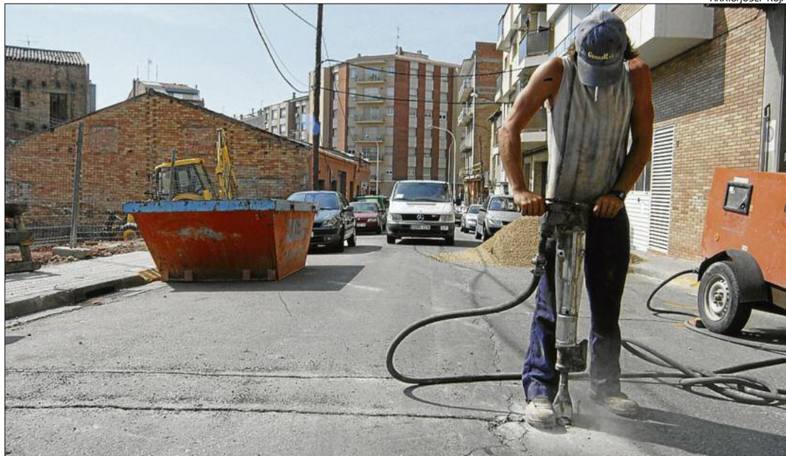
Un operari treballava en unes obres de reforç del paviment en un carrer de Manresa, l'any 2004
