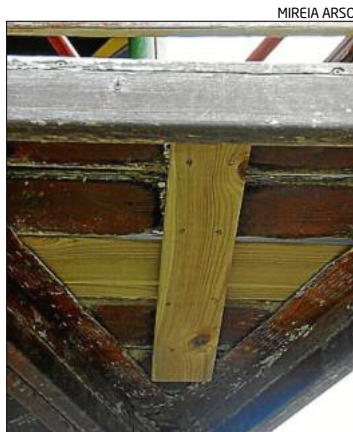
El tauló de fusta, ja reparat
