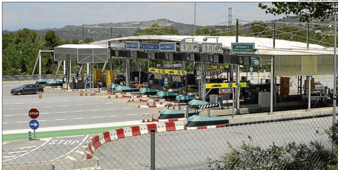
Barrera del peatge de l'autopista Terrassa-Manresa situada entre Castellbell i Sant Vicenç
